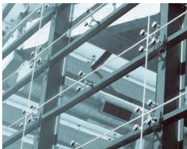
FACCIAE CON FISSAGGIO PUNTUALE
